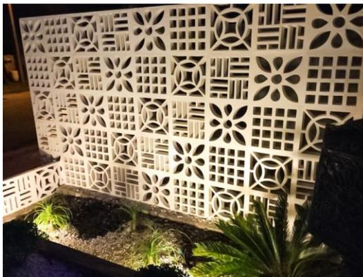
Assentamento de elemento vazado de concreto natural (cobogó) deve ser feito com blocos de 39x39x10 cm sobre argamassa cimento e areia, traço 1:3.
