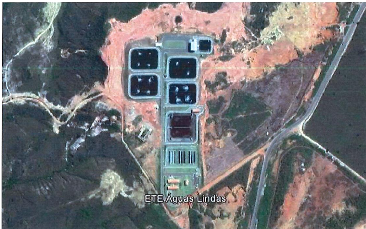
Figura 13. ETE de Águas Lindas de Goiás - 2020
